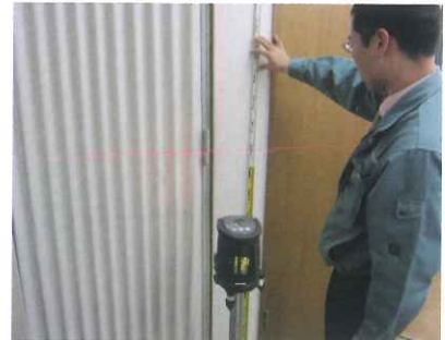
建物内部レベル測定
