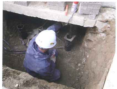
アンダーピーニング工法
