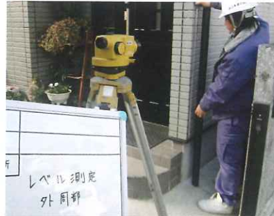
建物外部レベル測定
